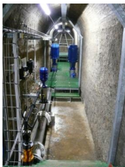
Photo : Réhabilitation du puits de la cote des Roches
