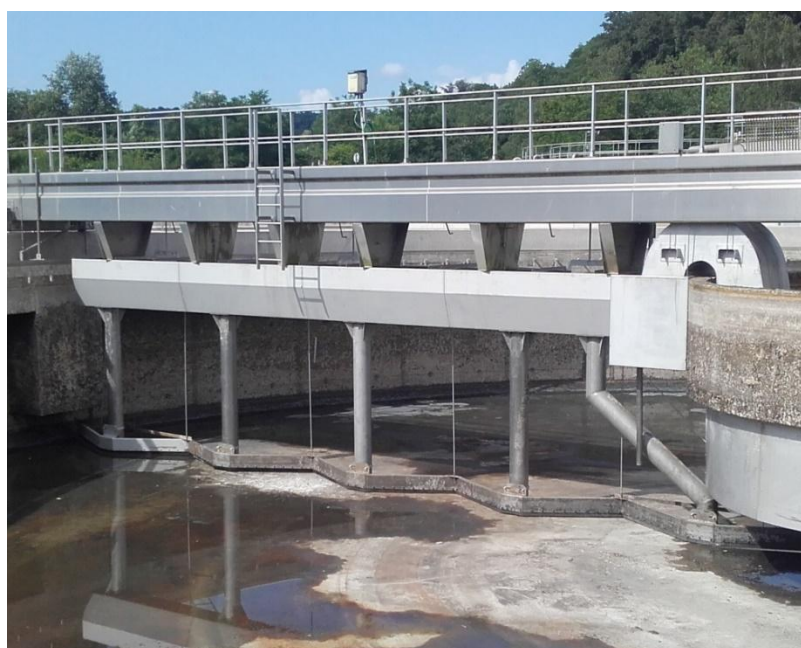
Travaux Clarificateur : réhabilitation goulotte et pont
