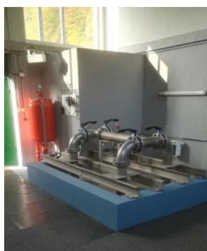
Photo : Réhabilitation du puits d'Haropré
